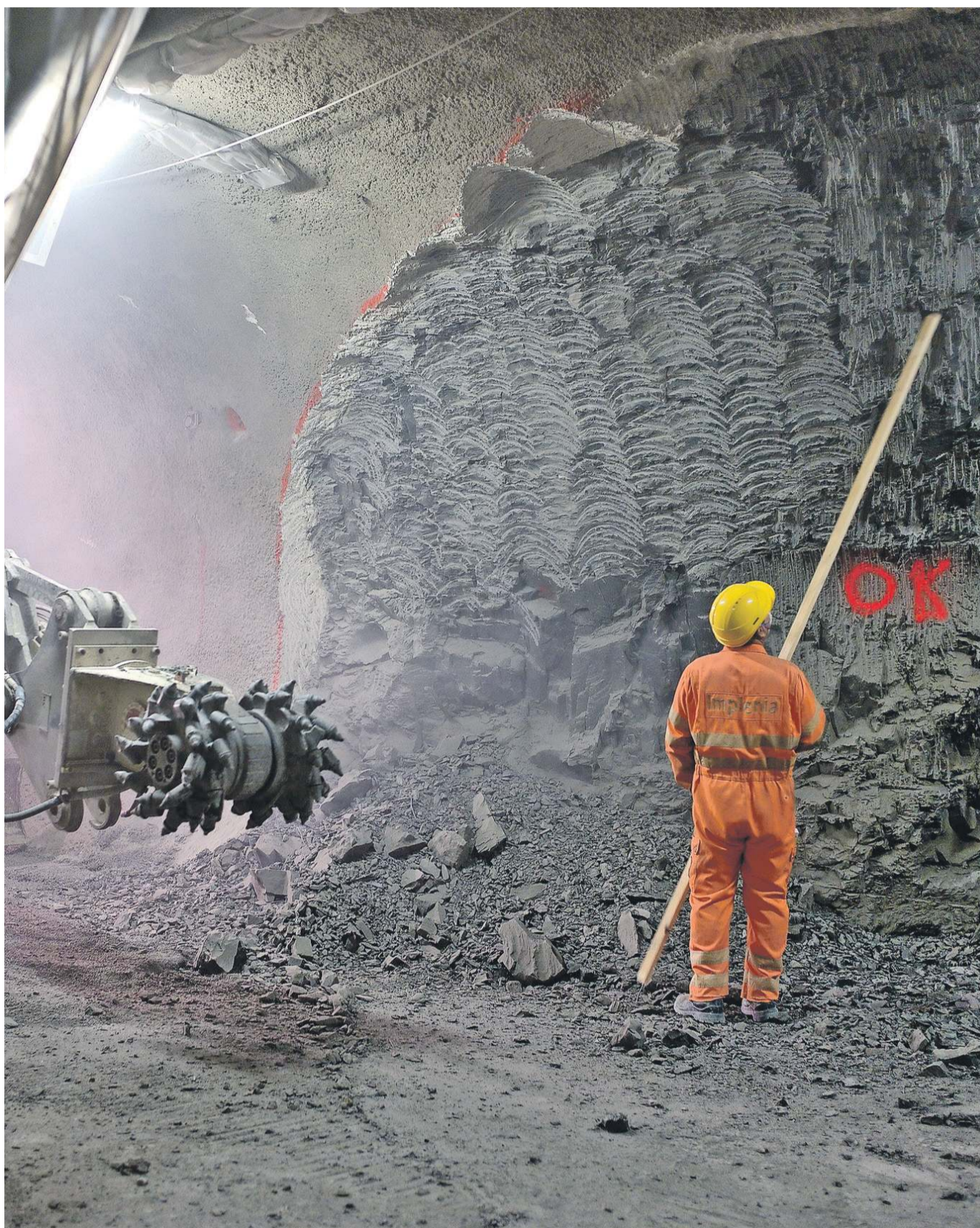
Des ouvriers creusent la roche du Mont-Terri (JU), susceptible d'accueillir des déchets nucléaires ou du CO 2 . KEYSTONE
